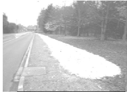
Suite aux travaux d'aménagement de la traversée de REUIL, la largeur du trottoir a été érodée par le temps. Il a donc été décidé, par mesure de sécurité de combler le fossé.
