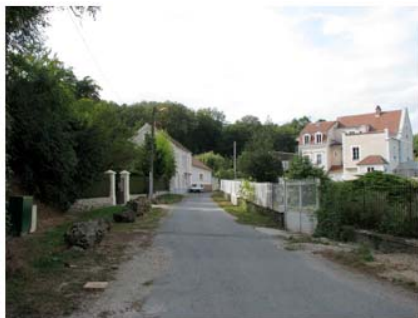
Bâti de caractère
